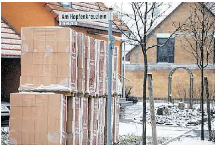
Auch im Winter wird gebaut: Die Beliebtheit des Neubaugebietes am Hopfenkreuzlein ist ungebrochen und es sind nur noch wenige Bauplätze frei. Was danach kommt, und in welche Richtung die Stadt sich weiter dehnt, muss im Stadtrat besprochen werden.
